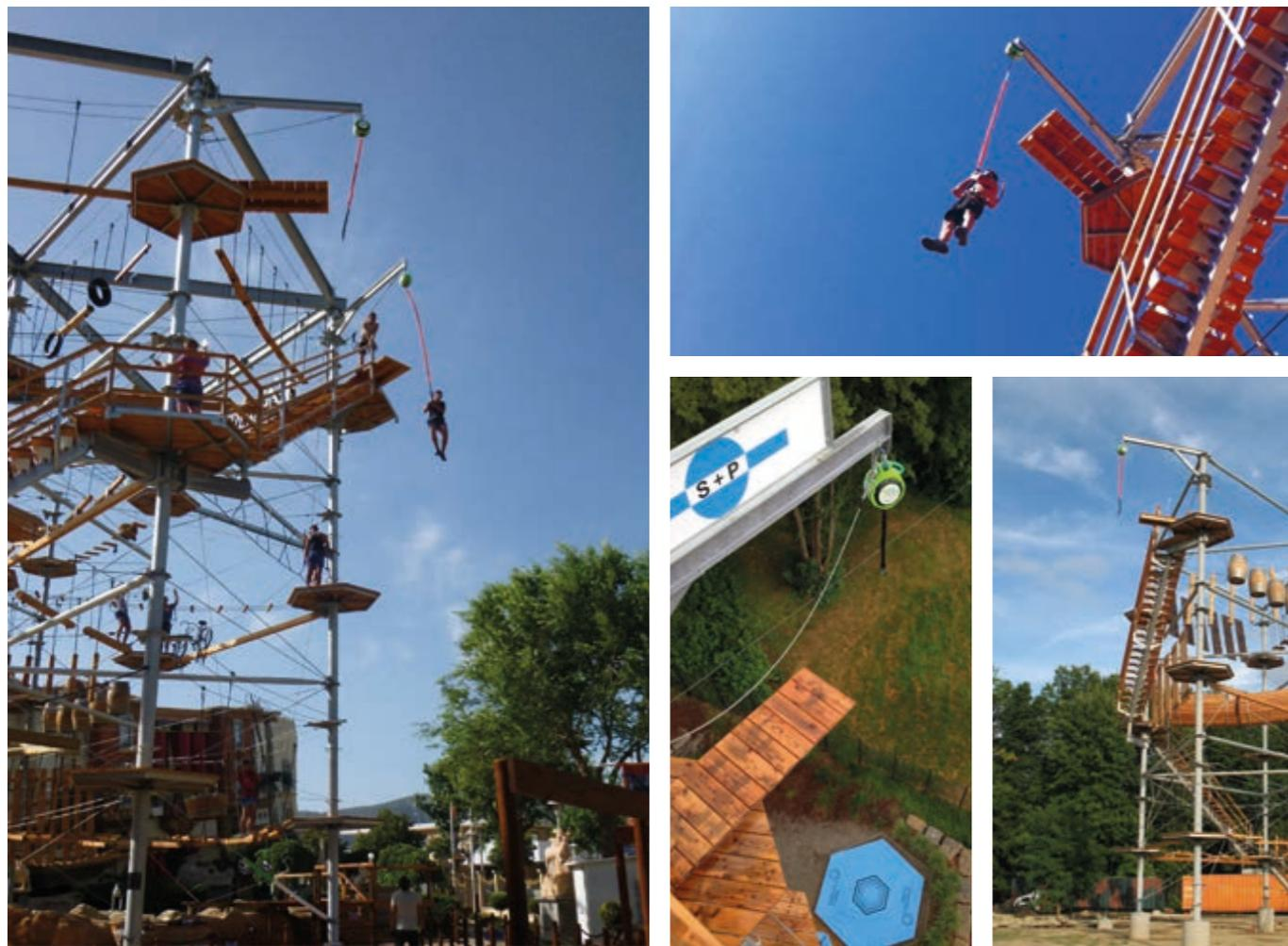
Con este complemento, el visitante se lanza al vacío y vive una experiencia de auténtica caída libre. El sistema de frenado del dispositivo ralentiza la caída. De esta forma, asegura el descenso controlado del visitante hasta el suelo. Un auténtico subidón de adrenalina y una atracción distinta para visitantes de cualquier edad. El sistema requiere muy poco mantenimiento. Es adecuado tanto para niños como para adultos y permite una gran afluencia de uso.
